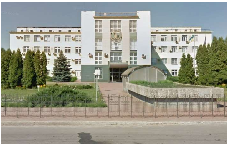
Рисунок 1.1 – Адміністративна будівля заводоуправління ПАТ «Сумихімпром»
